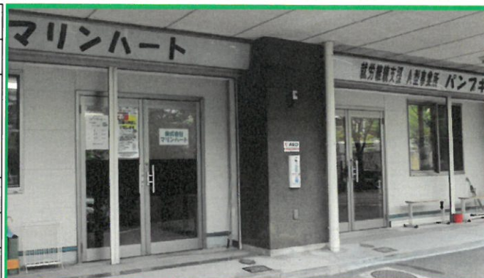
市営「新港栄荘1階店舗」
