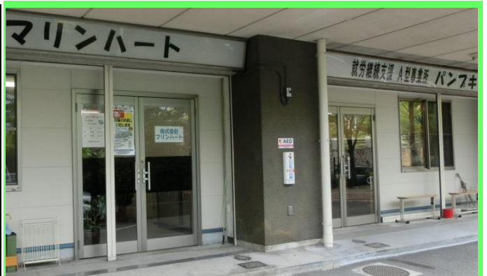
市営「新港栄荘 1 階店舗」
